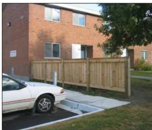
Clôture de périmètre
